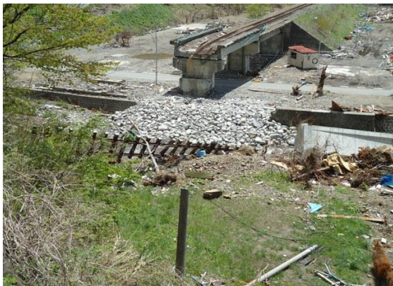
南リアス線 荒川橋梁（吉浜～唐丹間）
