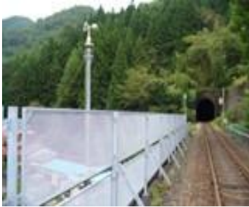
三杯式風速計と防風柵
