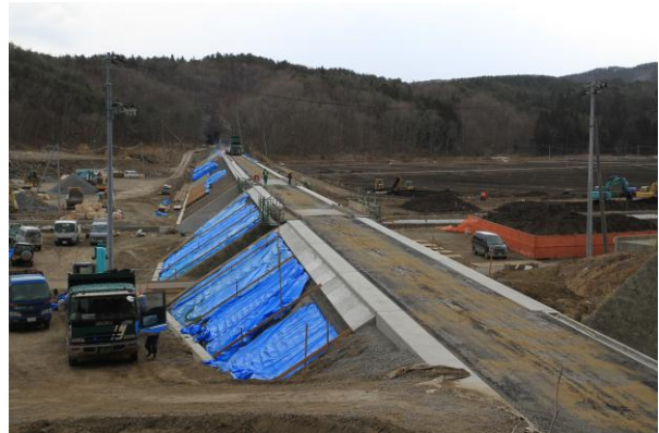
法面復旧工事
