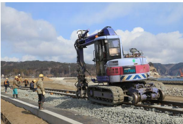
レール敷設工事
