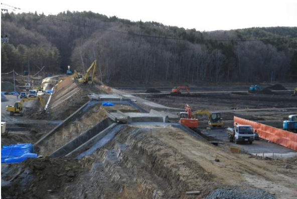
路盤復旧工事
