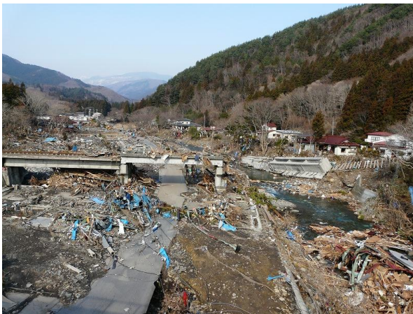
南リアス線荒川橋梁
