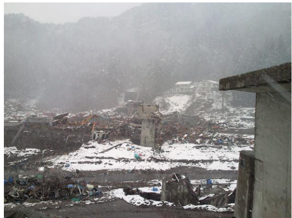
北リアス線島越駅
