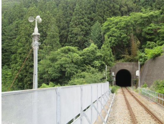
三杯式風速計と防風柵
