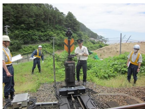
転てつ器手動転換での進路構成
