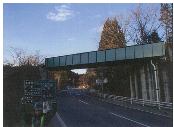
橋梁改修（塗装後）
