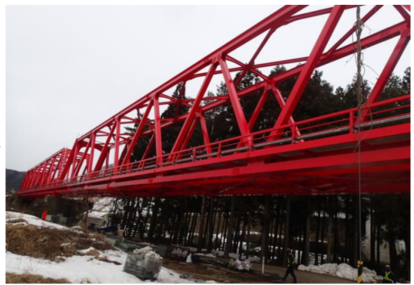
橋梁改修（塗装後）
