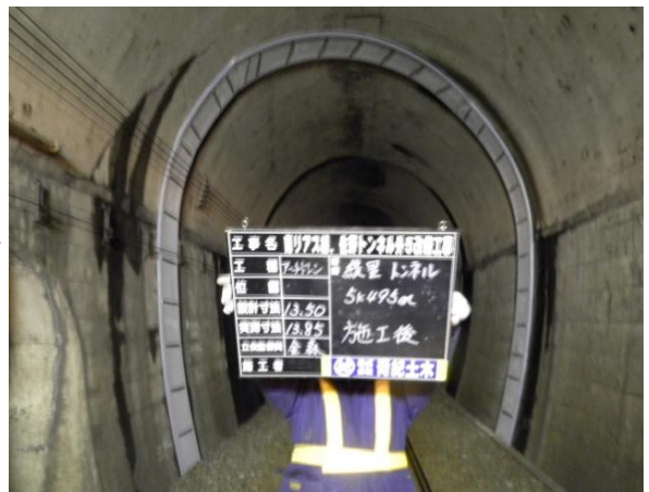
トンネル改修（施工後）
