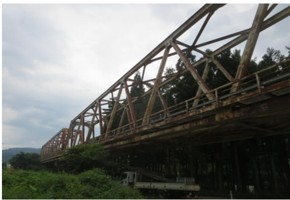
橋梁改修（塗装前）
