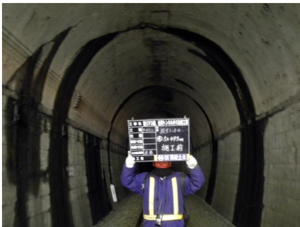
トンネル改修（施工前）
