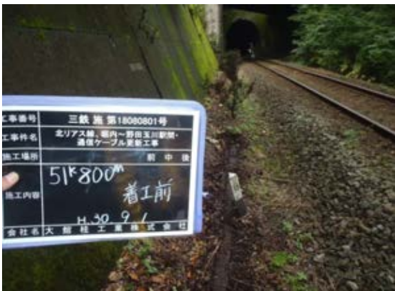
通信ケーブル更新（施工前）
