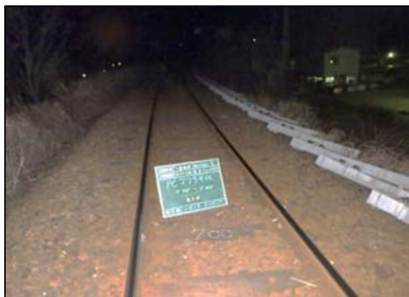
枕木交換（施工前）
