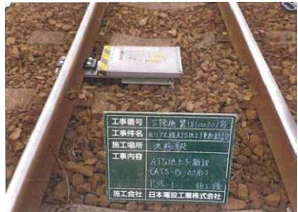
ATS更新新設（施工後）
