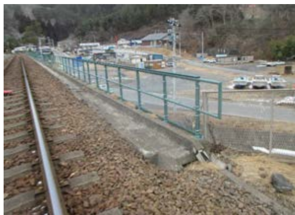
橋梁改修（塗装後）
