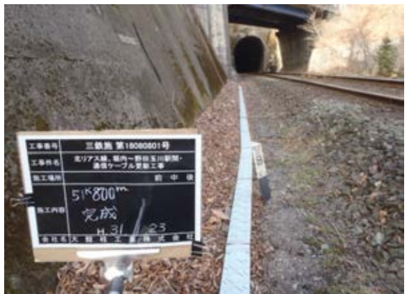
通信ケーブル更新（施工後）
