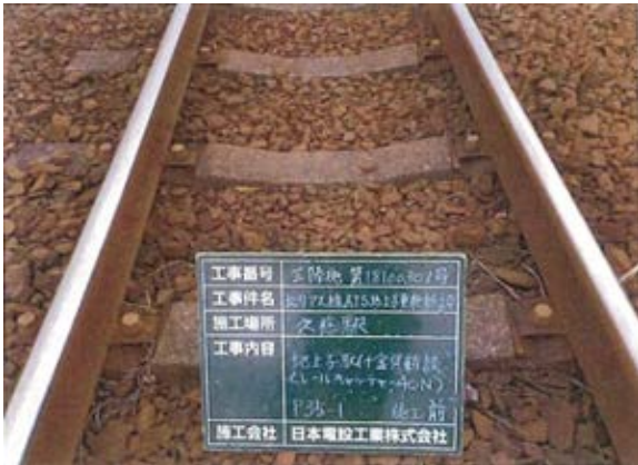
ATS更新新設（施工前）
