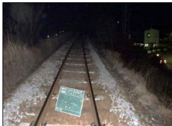
枕木交換（施工後）
