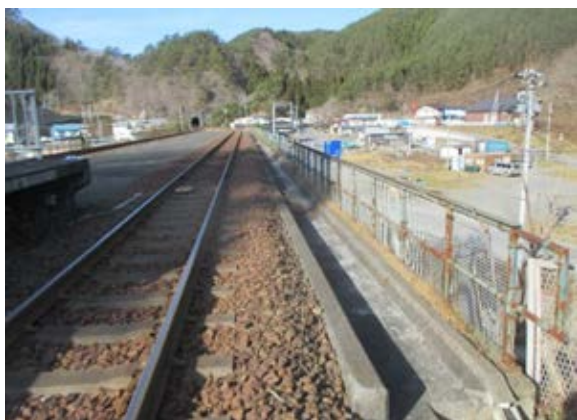
橋梁改修（塗装前）
