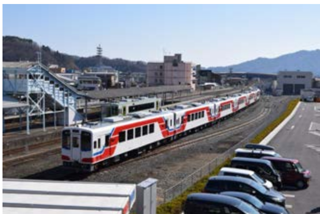
リアス線開業に向けて新たに整備した宮古車両基地と完成したばかりの車両
